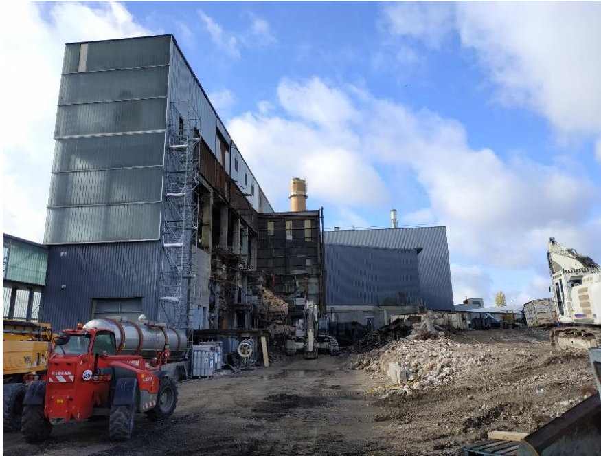
Figure 4 : État des travaux à la fin de la campagne de mesure (10/11/2023)
